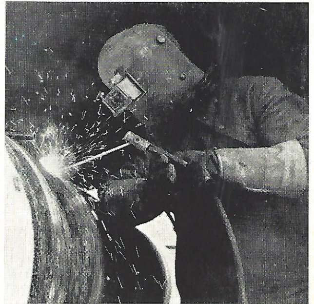
LASSEN. De pijpen worden aanéngelast tot één lange leiding. Eventuele lasfouten worden door middel van röntgenapparatuur gecontroleerd.
